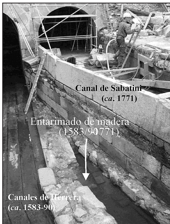
Figura 1. Complejo del Real Ingenio de la Moneda de Segovia (izquierda). Detalle del canal original de Juan Herrera cubierto por el entarimado de madera, y canal de mampostería y sillería de granito, cubriendo parte de ese entarimado (derecha)
