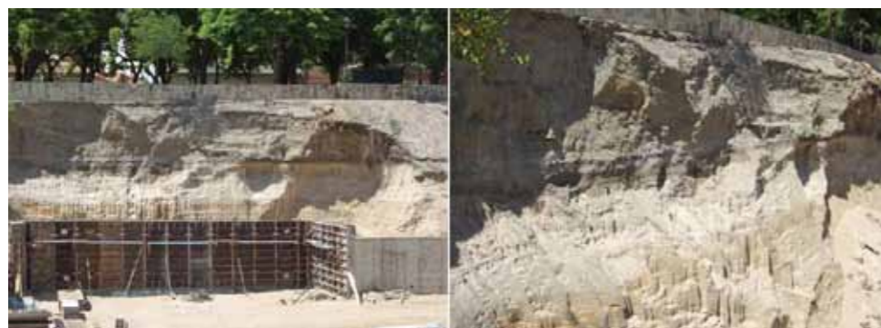
Figura 5. Afloramiento del talud del parque en el graderío hacia el antiguo campo de fútbol, que quedó al descubierto tras el derrumbe motivado por la tormenta de 2007, donde se pueden distinguir los tres niveles de subarcosas pleistocenas (abajo), arcosas del manto eólico, y el relleno antrópico.
