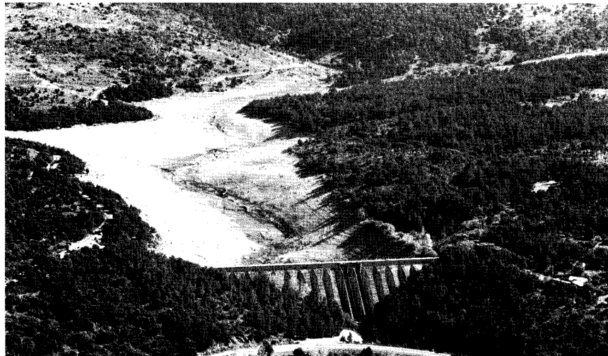
Figura 4. Vista aérea oblicua de la presa de Puente Alta, así como de su cuenca vertiente, al inicio de las obras de impermeabilización del paramento durante el verano de 1995 (en Rodríguez, 1996)
