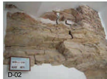
Afloramiento de alternancia de arenas y limos en la entreplanta del portal Cervantes 17.
